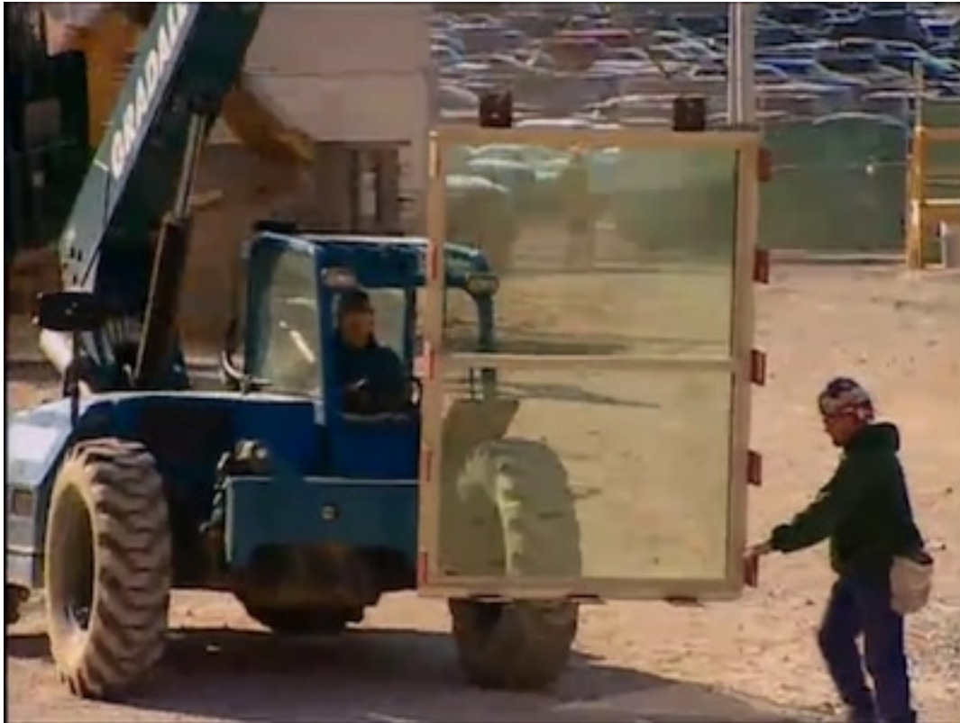
Figura 29. Una delle finestre antiscoppio del Pentagono. Si notino le dimensioni ragguardevoli del veicolo sollevatore, necessarie per gestire serramenti che pesano oltre una tonnellata l'uno. Credit: Inside the Pentagon, di National Geographic.
