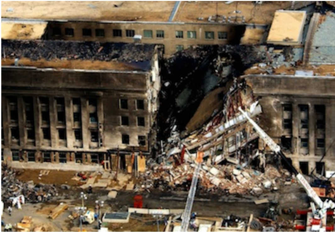
Figura 20. La facciata del Pentagono dopo il crollo. Credit: Cedric Rudisill.
