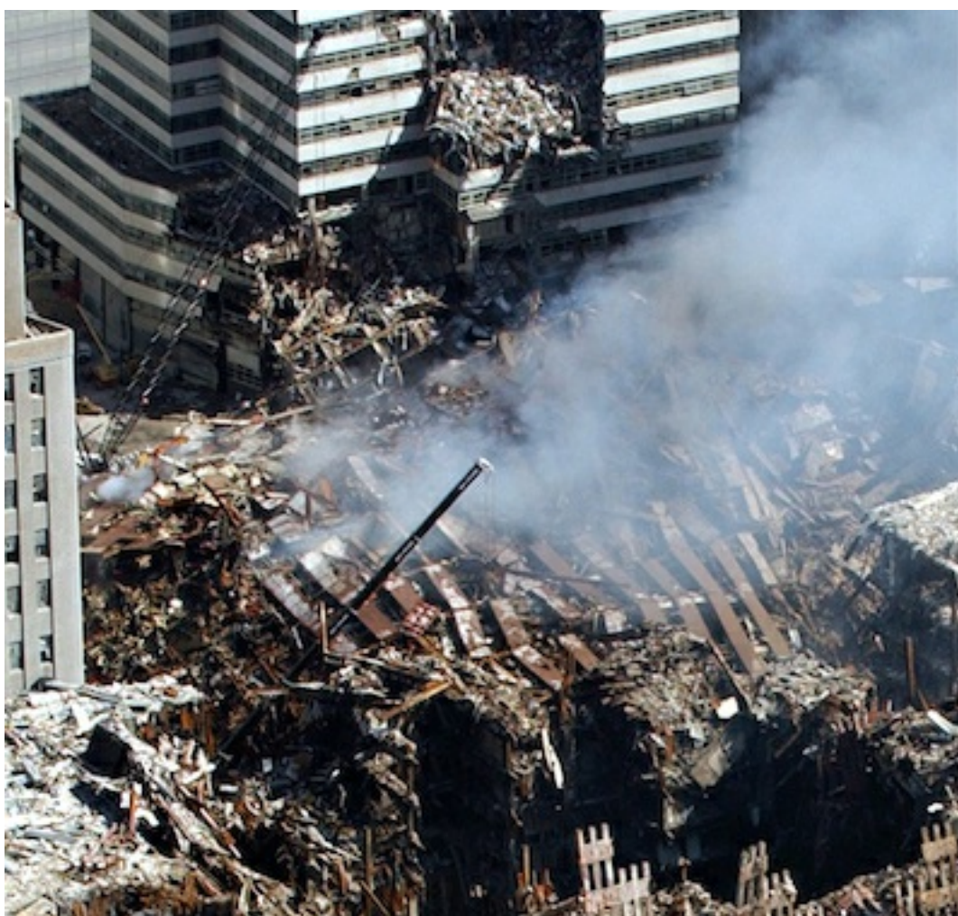
Figura 21. Al centro, la facciata del WTC7 distesa a coprire le macerie. Le Torri Gemelle sorgevano a destra, in primo piano. Le macerie del WTC7 si riversarono anche sull'edificio adiacente, la Fiterman Hall (in alto).
