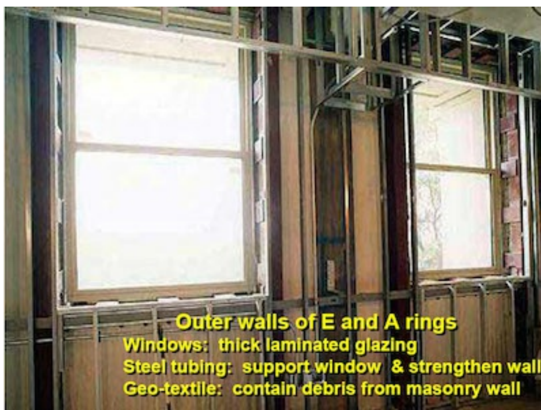
Figura 28. Le finestre antiscoppio viste dall'interno. Credit: Department of Defense.
