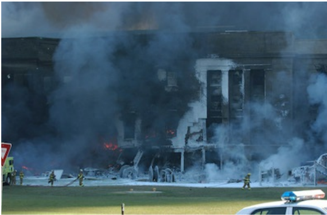
Figura 4. Un'immagine della breccia senza la copertura del getto dell'idrante ne rivela la vera estensione. Credit: Jason Ingersoll.
