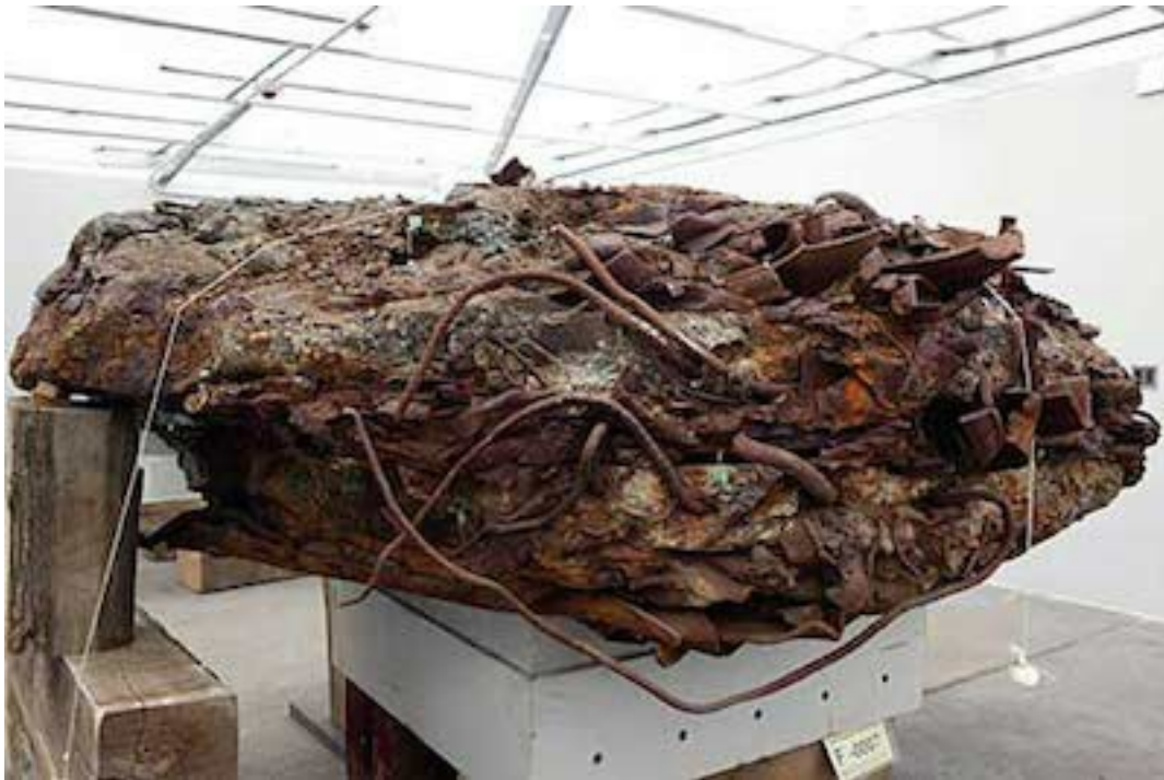
Figura 8. La vera natura del “blocco di metallo fuso”: cemento e tondini metallici compattati dalla pressione delle macerie.
