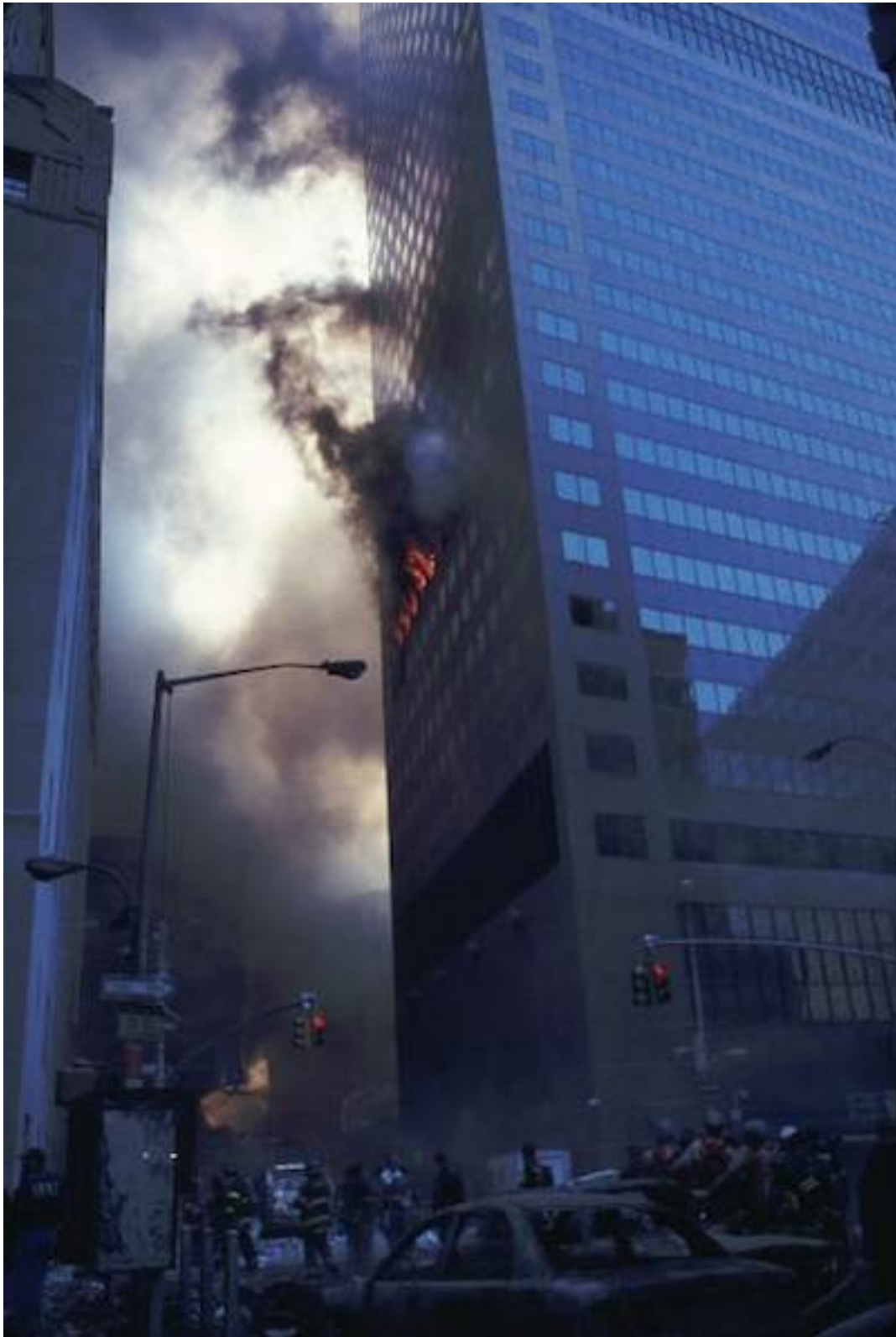
Figura 4. L'immagine del WTC 7 comunemente mostrata dai teorici del complotto dell'11/9, che presenta quel che pare soltanto un minimo danno all'edificio.
