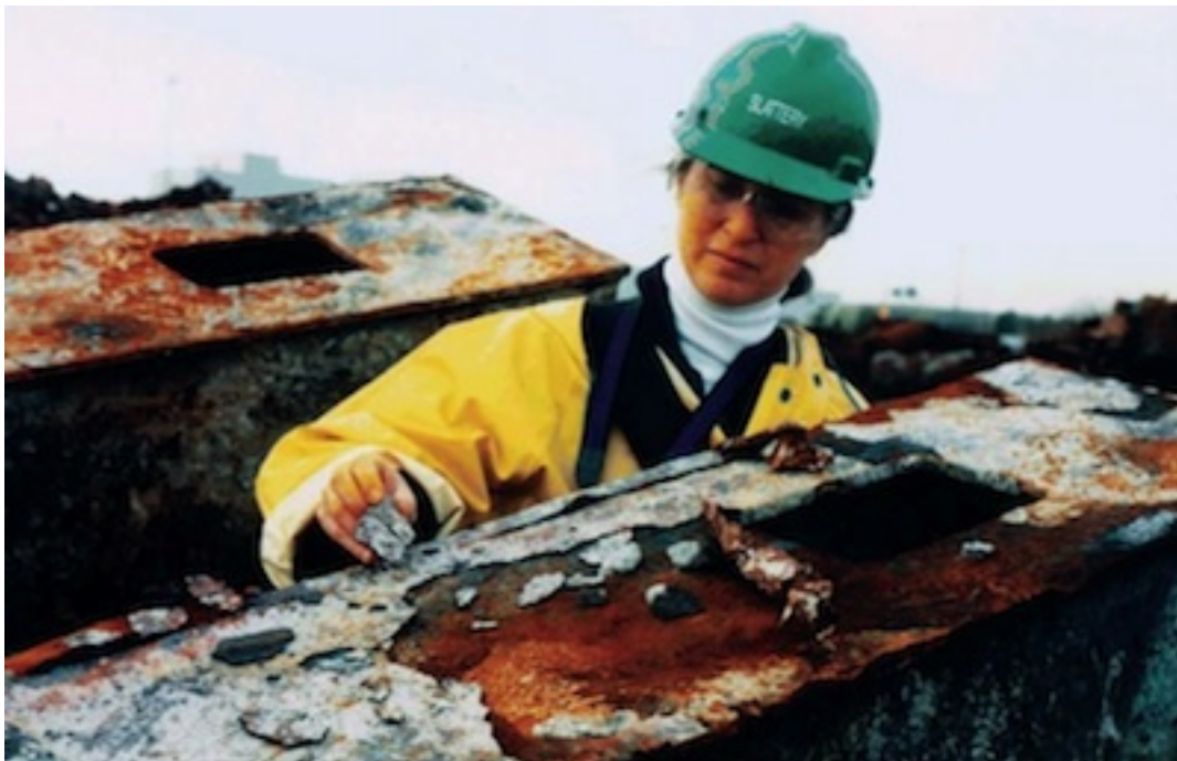
Figura 27. Un'ingegnere esamina il metallo del WTC. Dal rapporto FEMA.
