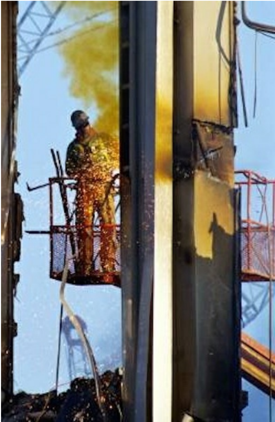
Figura 14. Taglio a cannello delle parti restanti della facciata delle Torri Gemelle.
