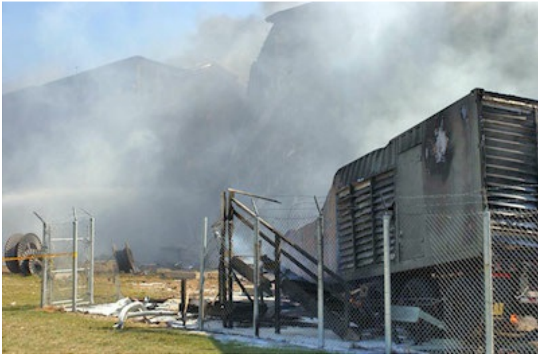
Figura 19. Il generatore (a destra) ha lo spigolo superiore tranciato lungo la traiettoria d'impatto. Credit: Jason Ingersoll.
