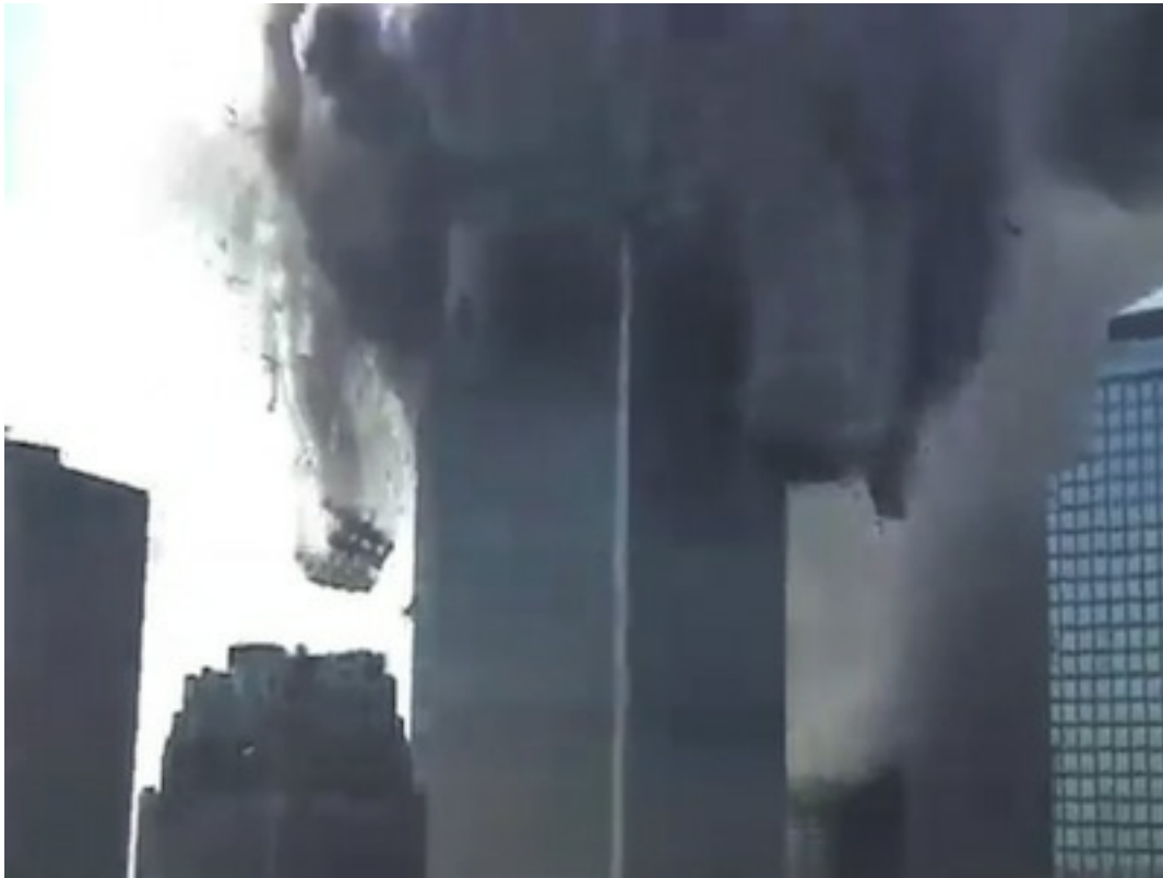
Figura 3. Dei frammenti di facciata precipitano in caduta libera ai lati del WTC1, precedendo vistosamente il fronte del crollo. Dal “video di Bob e Bri” ( http://wtcbpc.blogspot.com ).
